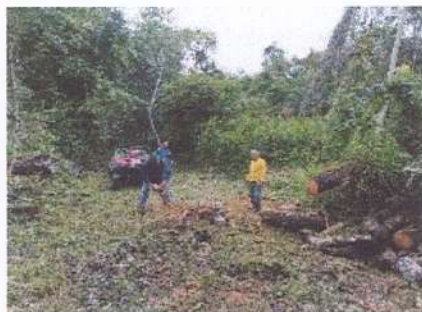
Limpieza de brecha sur
