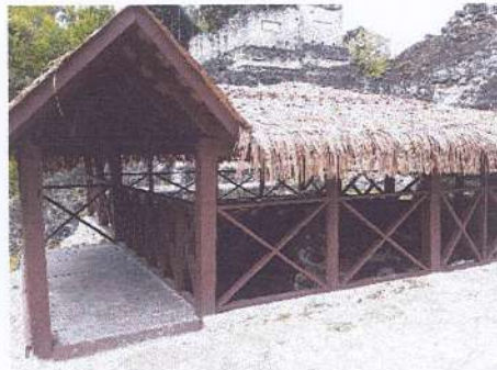
Verificación de techo en escultura Cha'ak
