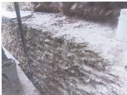
Avance en consolidación de Templo V
