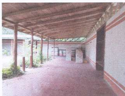
Verificación condiciones estelas
