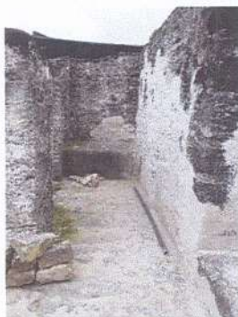
Consolidación Estructura 5D-22
